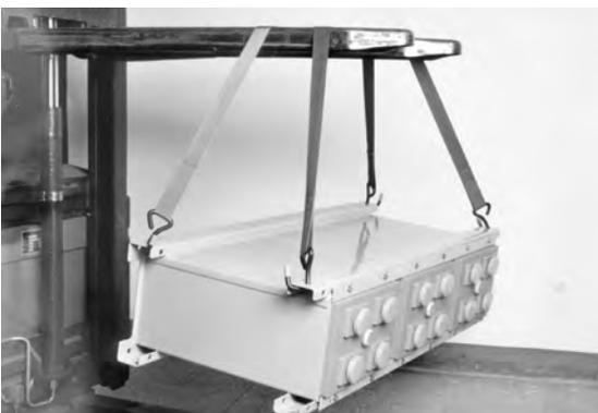
Рис. 5: Установка ящика с модулями на швеллеры основания
