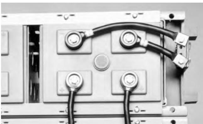
**Рис. 8:** Присоединение отводов между клеммами элемента и платой основного полюса
