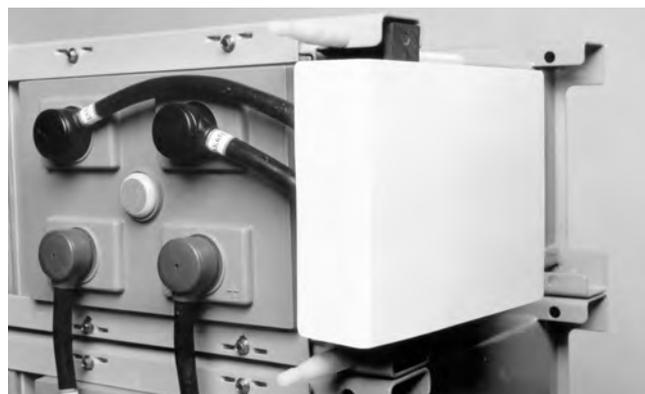
**Рис. 9:** Крепление съемной панели экрана к съемным соединителям главной клеммы
